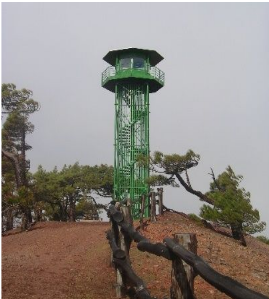
Imagen 1: Torre de Vigilancia "El Mercadel
