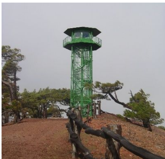
Imagen 4: Torre de Vigilancia "El Mercadel"
